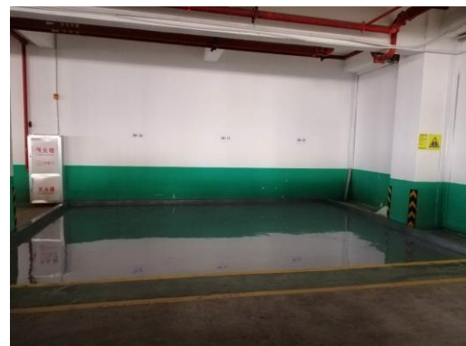
地面防渗措施一整改后
