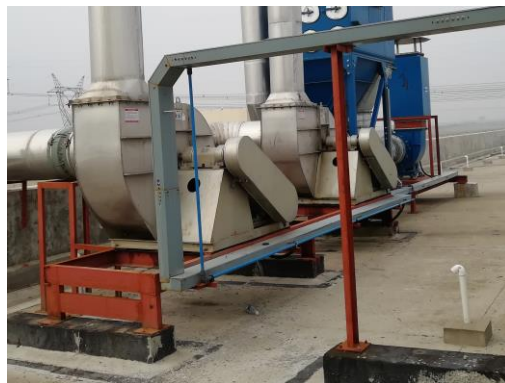
矿物油泄漏—整改后
