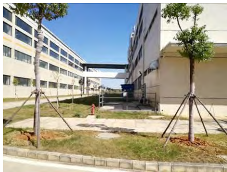
车间污水收集池
