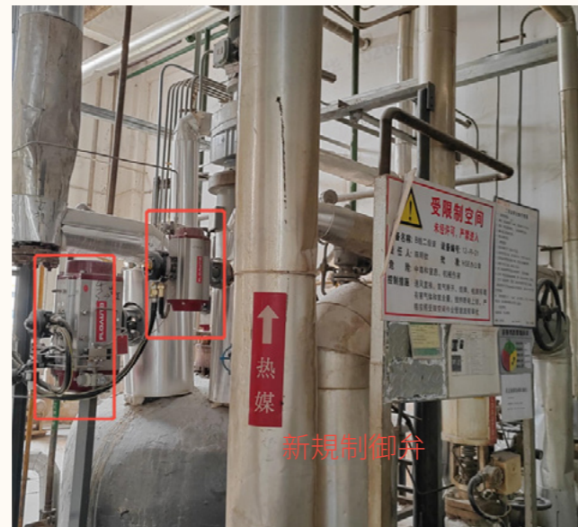
プロジェクトに増設した制御バルブ
