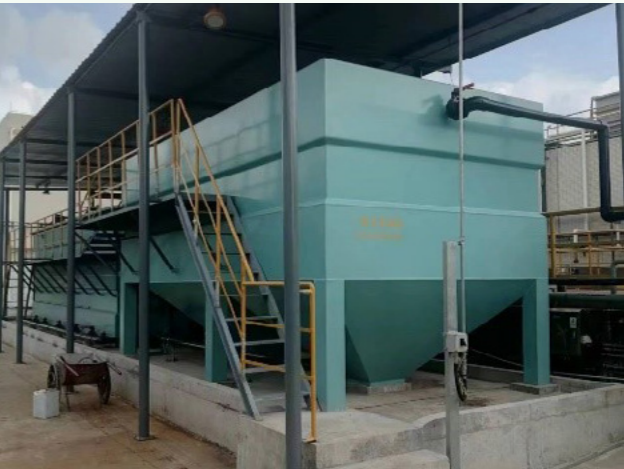
ナイロン生産用給水の前処理沈殿槽
